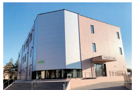
フードイノベーション棟
