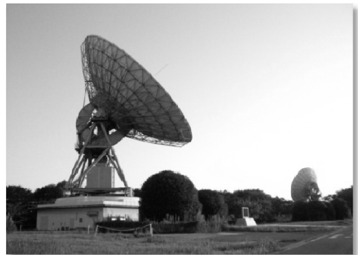
2基のパラボラアンテナ
