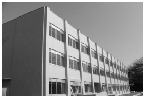
工学部N3棟
