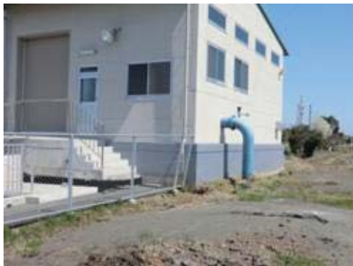
図 4.1 揚水機場の吐出し管の脱管（左）、機場周辺地盤の陥没（右）
