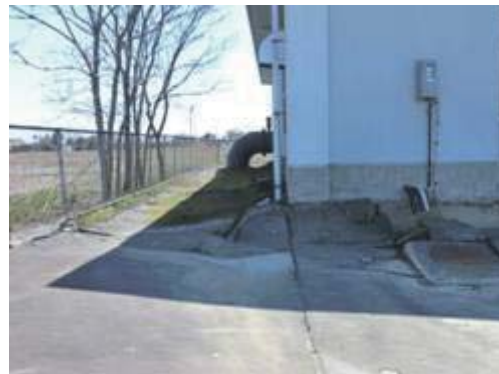
図 4.1 揚水機場の吐出し管の脱管（左）、機場周辺地盤の陥没（右）
